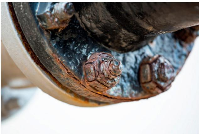
Die fortgeschrittene Flanschkorrosion stellt eine Gefahr für die Betriebssicherheit dar
