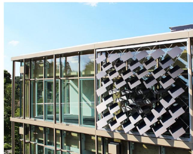
Das System umfasst zwei selbstlernende Robotikeinheiten, die die Modulausrichtung über den gesamten Tag hinweg optimieren und auch an Wetteränderungen anpassen. Die Prototypen generieren Testdaten, mit denen wir Energieproduktion und -effizienz mit anderen Systemen vergleichen können.
